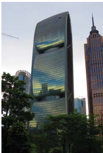
图4. 广州珠江塔。运用了它雕塑化的幕墙引导风流通过位于它立面凹陷处的涡轮机 ©Tansri Muliani
