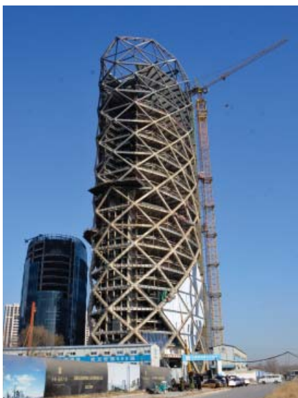
图11. 北京的保利国际广场，使用了斜肋构架系统，混凝土填充的管体从底部打破顶部直径从1.3m-0.7m不等，厚度从50mm-20mm不等。支撑楼层在端点之间和斜肋构架相连。中间的楼层则是从上部楼层悬挑出来的。
