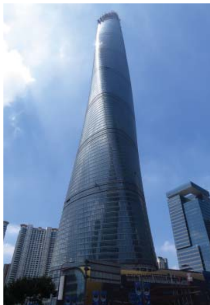
图14.最近刚刚竣工的上海中心双层幕墙系统，在结构层的外部添加了一层轻盈而复杂的几何立面。 © Tansri Mulliani
