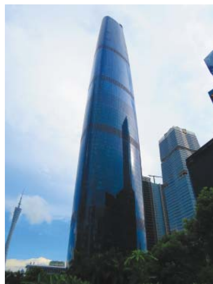
图12. 广州国际金融中心，光滑轻亮的外表皮背后是钢板斜肋构架。这个微微弯曲的曲面型塔楼只有借助先进的电脑系统帮助才能实现。© Tansri Muliani
