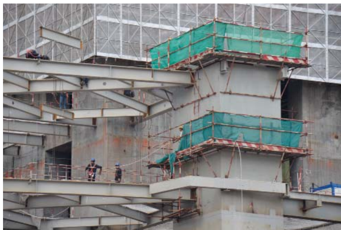
图7. 上海中心的双层幕墙系统;广州周大福中心的巨型柱子;巨型柱已经成为高层建筑结构的核心构件，同时也成为影响建筑表达的因素。
