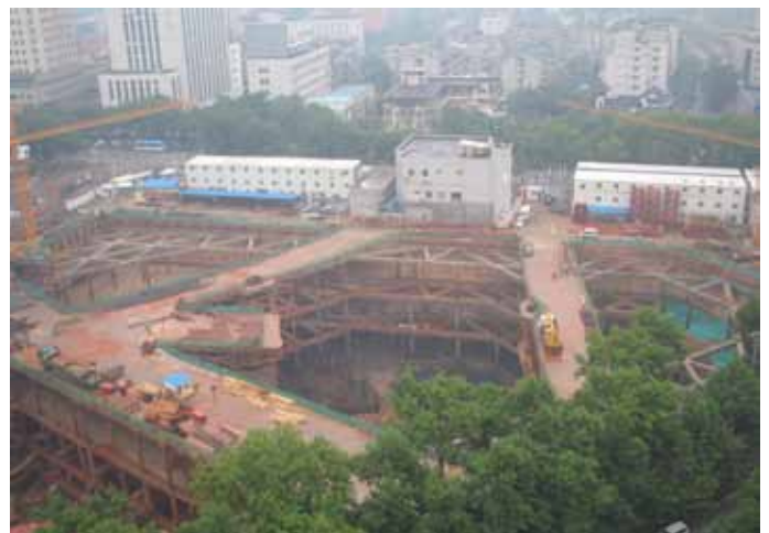
Figure 7. Nanjing Zifeng Tower under construction 图7. 施工中的南京紫峰大厦
