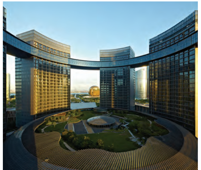
Figure 4. Court View of Hangzhou Civic Center (Source: Linxue Li) 图4. 杭州市民中心庭院透视 (来源: 李麟学)
