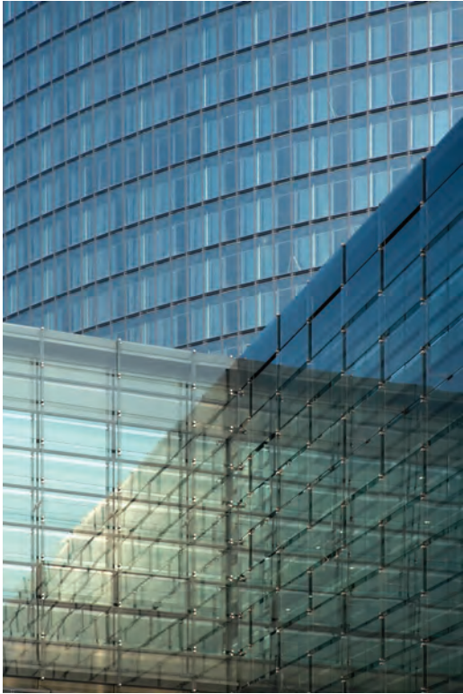
Figure 10. Façade Detail 2 of Hangzhou Civic Center (Source: Linxue Li) 图10. 杭州市民中心幕墙细部二 (来源: 李麟学)
