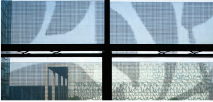
Figure 9. Façade Detail of Hangzhou Civic Center (Source: Linxue Li) 图9. 杭州市民中心幕墙细部一 (来源: 李麟学)
