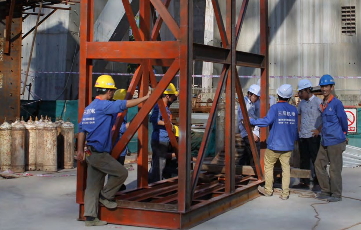
Figure 6.27. Site management team (Source: Ping An) 图6.27. 平安金融中心施工现场管理 (来源: 平安)
