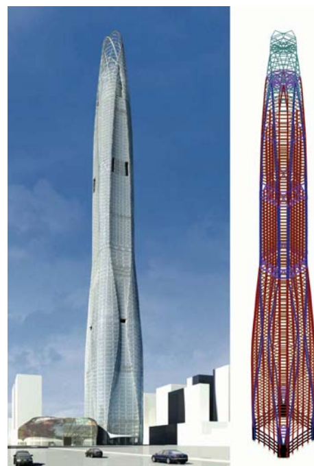
Figure 8. Rendering of New World CTF with diagram of structural system (Source: SOM) 图8. 中国天津周大福滨海中心发展项目效果图带结构系统图（来源：SOM）
