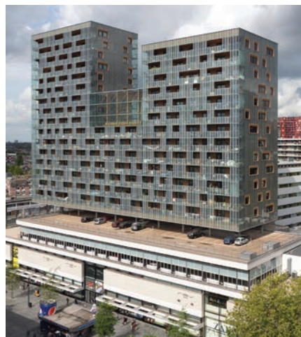
Figure 7. De karel Doorman, Rotterdam. © Ossip van Duivenbode/lbelings van Tilburg
