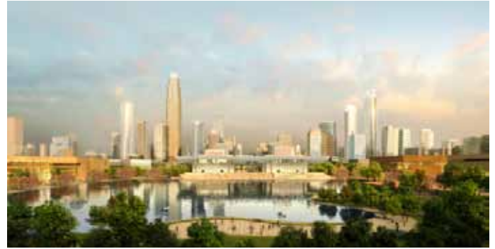
Figure 12. Tianjin Cultural Center (Source: SOM) 图12. 天津文化中心 (源自: SOM)
