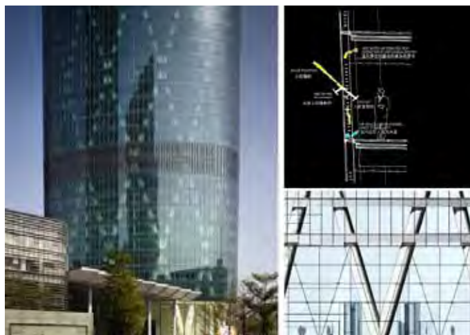
Figure 5. Cladding 图5. 外立面
