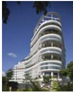
Solaris大厦 新加坡, 2011 建筑高度: 79 m 层数: 15
