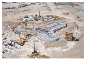
Figure 6. The concrete base for the tower. 图6. 哈利法塔的混凝土地基
