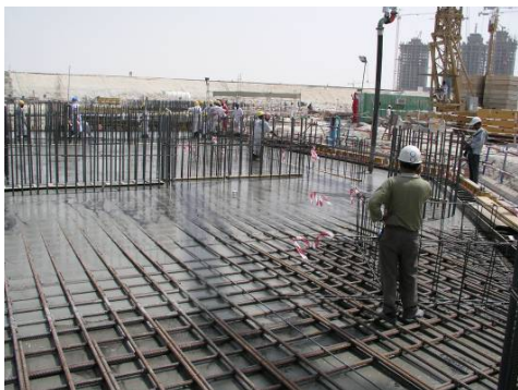
Figure 9 - Reinforced Concrete Raft Pour
