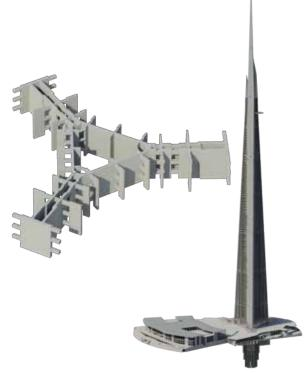
Figure 8. Kingdom Tower structural scheme. (Source: Jeddah Economic Company/ Thornton Tomasetti) 图8. 王国大厦的结构方案(出自: 吉达经济公司/ Thornton Tomasetti)
