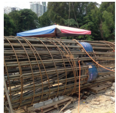
Figure 6. O-cell test (Source: PMV) 图6. 自平衡测试 (来源: PMV)
