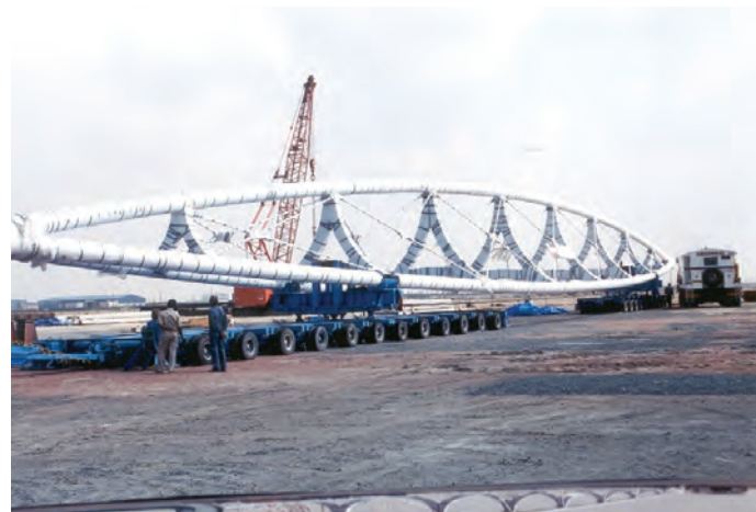
Figure 7. All steel wrapped in polyurethane (Source: Jotun) 图7. 所有钢结构外包覆聚氨酯胶带用来在运输过程中保护漆膜 (来源: 佐敦)
