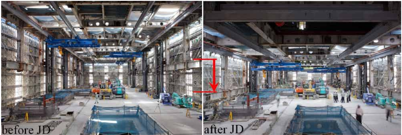
Figure 10. Safety and automatically jack-down system (source:TAISEI Corp.) 图10. 安全和自动下降系统（出自：大成建设）
