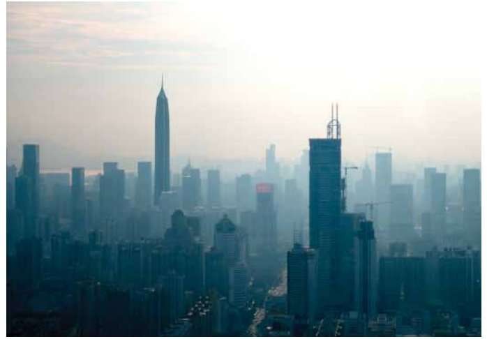
Figure 3. Ping An Finance Center on the Shenzhen skyline. (Source: KPF) 图3. 深圳天际线上的平安金融中心（来源：KPF）
